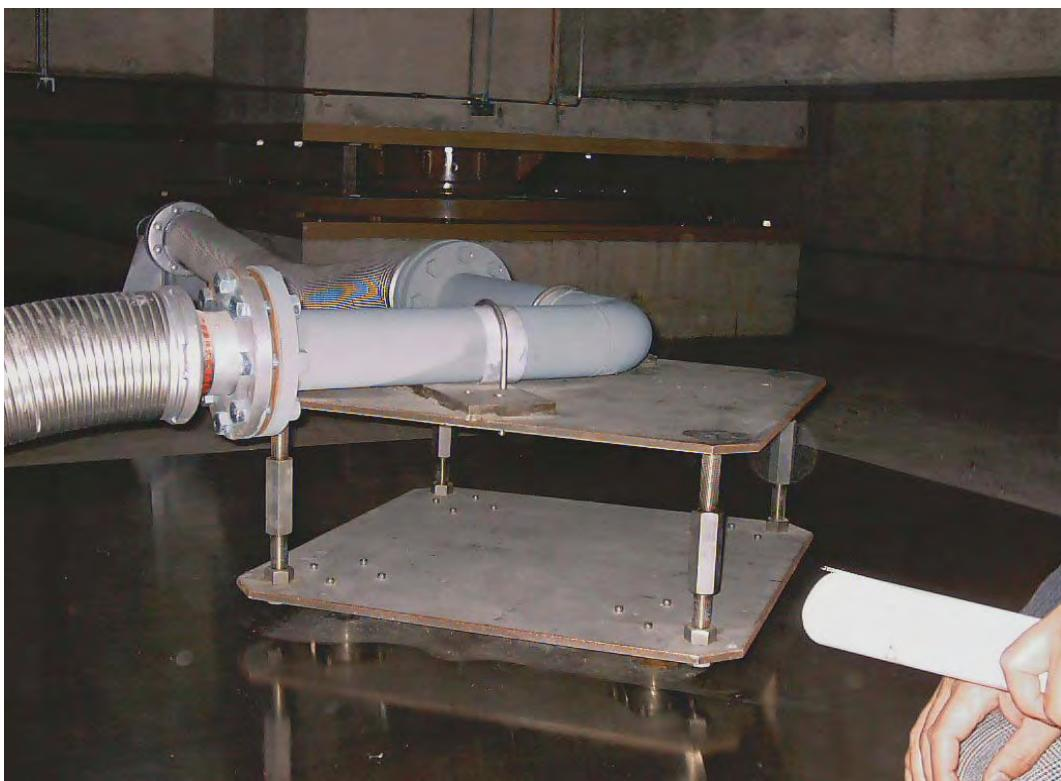
۳-۵-ب- استفاده از تکیه‌گاه متحرک در محل عبور لوله‌های تاسیسات انعطاف‌پذیر از طبقه‌ی جداسازی
