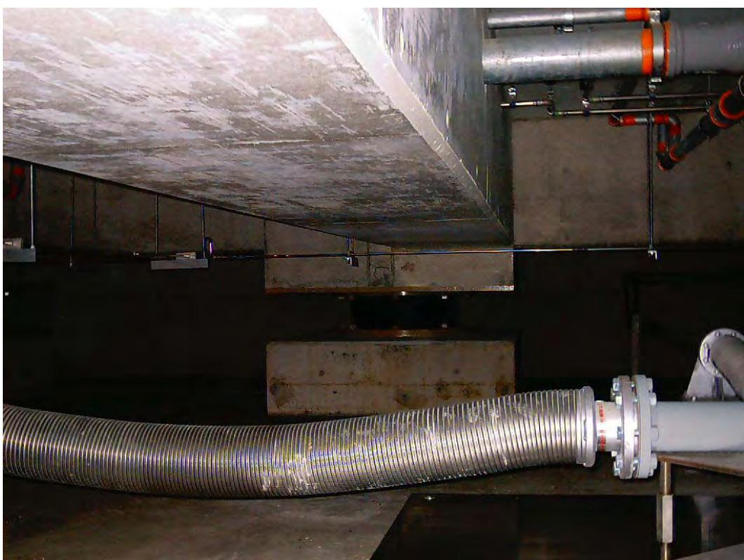
۳-۵-الف- استفاده از اتصالات انعطاف‌پذیر در محل عبور لوله‌های تاسیسات از طبقه‌ی جداسازی
