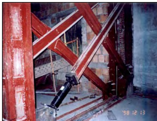
شکل ۷-۱۹- استفاده از میراگرهای ویسکوز در بادبندهای قطری
