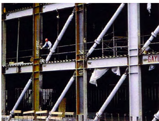
شکل ۷-۱۹- استفاده از میراگرهای ویسکوز در بادبندهای قطری
