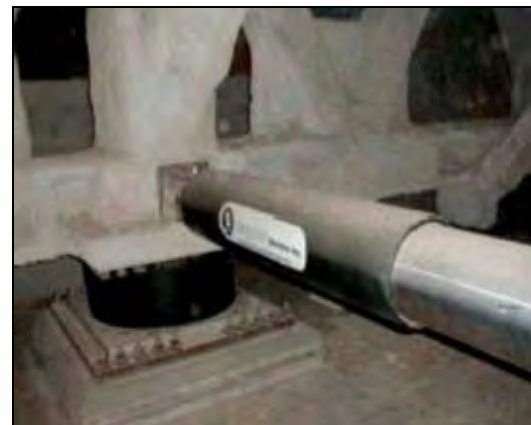
شکل ۷-۱۶- جزئیات تیپ سیستم میراگر ویسکوز
