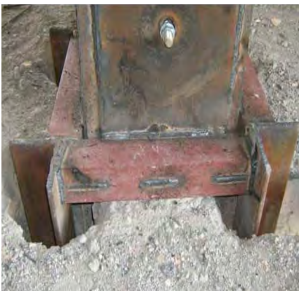
شکل ۲-۵-۱۲- نمونه‌ای از روکش فولادی جهت افزایش مقاومت خمشی ستون
