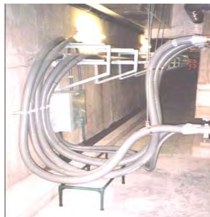
شکل ۶-۲۲ - استفاده از اتصالات مناسب برای تاسیسات مکانیکی و برقی در تراز جدا شده
