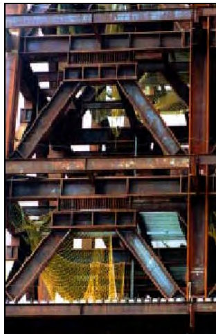
شکل ۷-۱۳- نمونه هایی از بکارگیری میراگر T-ADAS
