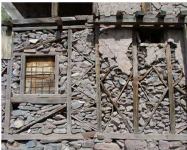
ب: ایجاد ترک بر روی مواد پرکننده دیوار
