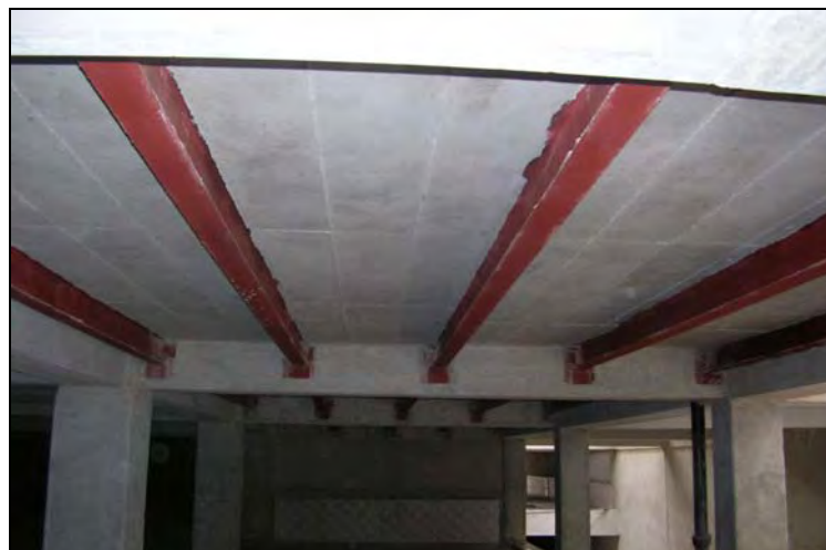
شکل ۲-۳-۵- اضافه کردن تیرک فولادی
