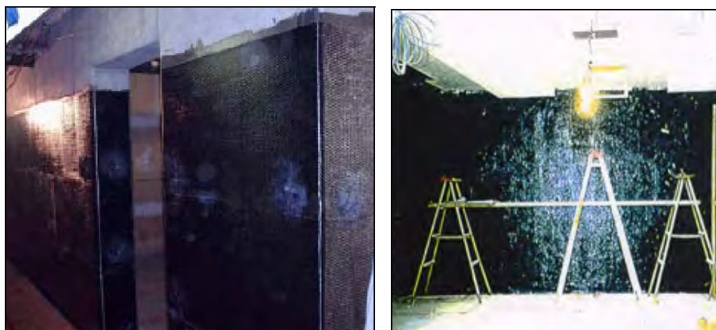
شکل ۴-۴۲- تقویت کلی دیوارهای برشی بوسیله مصالح FRP
