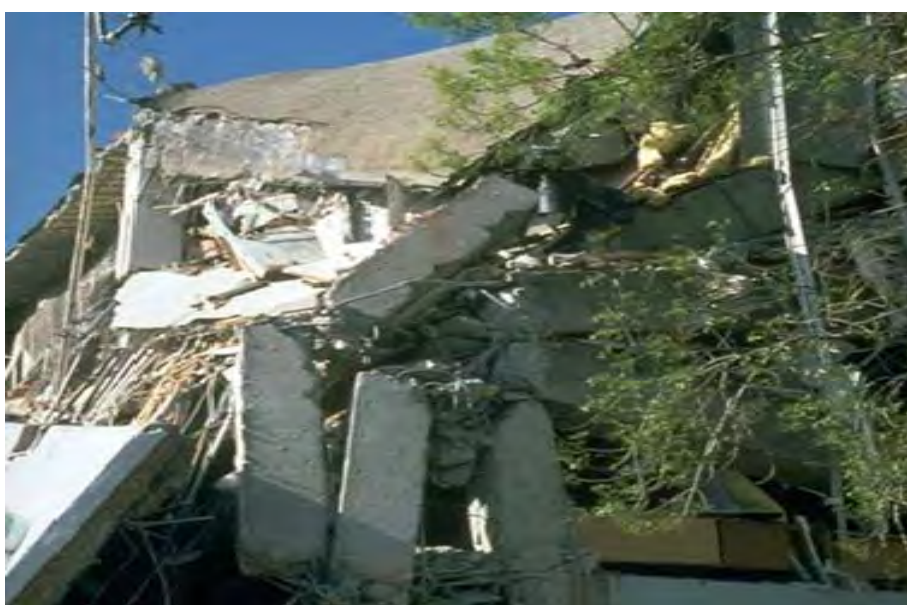
شکل ۲-۶-۵ نمونه‌هایی از شکست در اتصالات ضعیف بتنی
