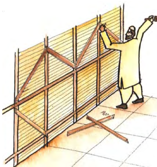
شکل ۹-۳۸ پیوستگی اعضای قطری
