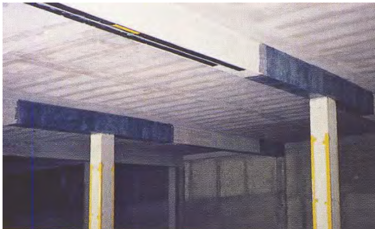
شکل ۲-۴-۸- کاربرد مصالح FRP در مقاوم‌سازی
