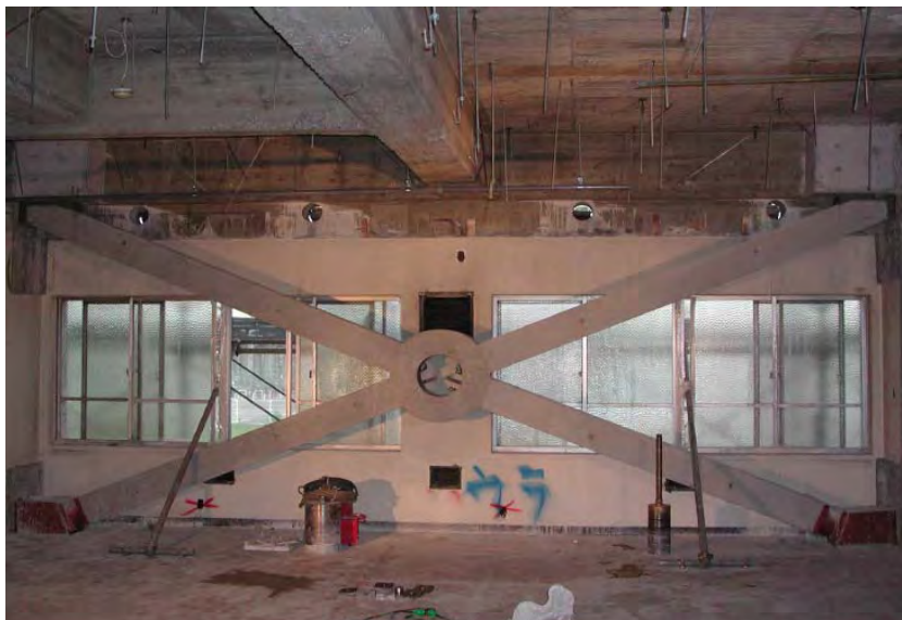
شکل ۴-۲۳- نمونه‌ای از مهاربند بتنی پیش تنیده و پیش ساخته
