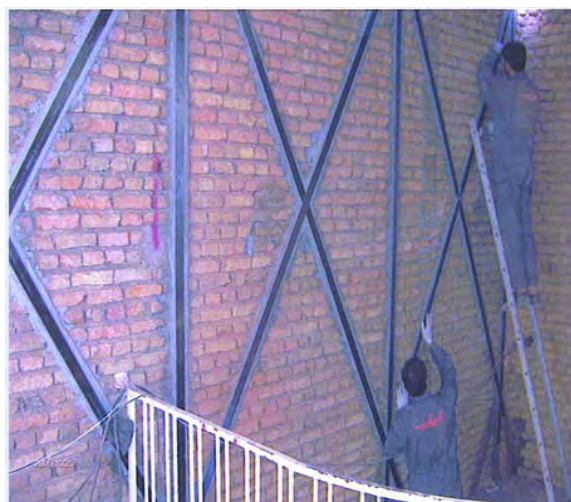
شکل ۸-۱۹ - نحوه اجرا و نصب نوارهای FRP
