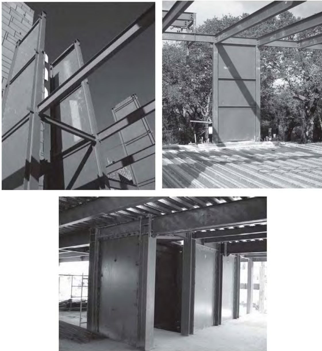
شکل ۴-۵۰- دیوار برشی فلزی
