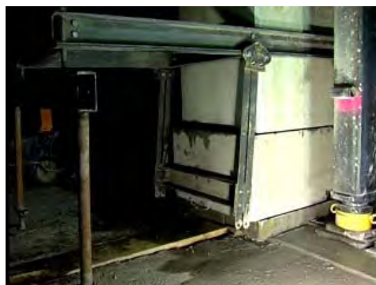
شکل ۶-۱۹ - خروج بلوک بریده شده
