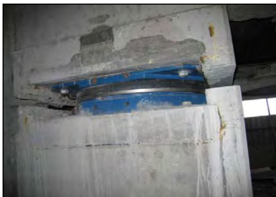
شکل ۶-۱۱ - جداگرهای اصطکاکی FPS
