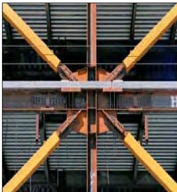
شکل ۴-۱۹- نمونه‌هایی از مهاربند ضد کمانش BRBF
