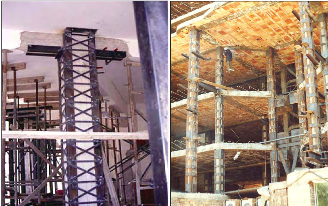
شکل ۲-۵-۱۳- بهسازی ستونهای بتنی بوسیله روکش فولادی قفسه‌ای
