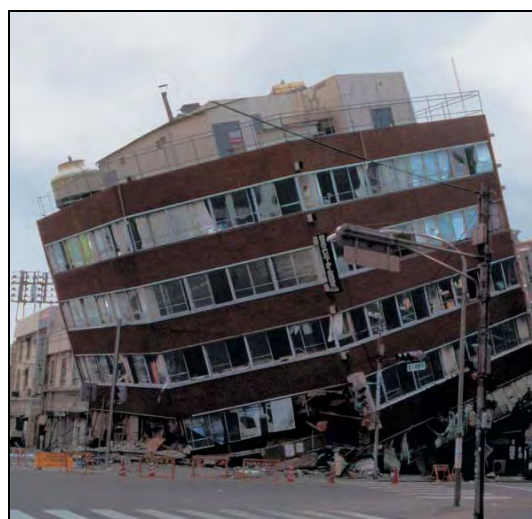
شکل ۳-۶- فاصله زیاد بین مرکز جرم و مرکز سختی و خرابی ناشی از ایجاد پیچش
