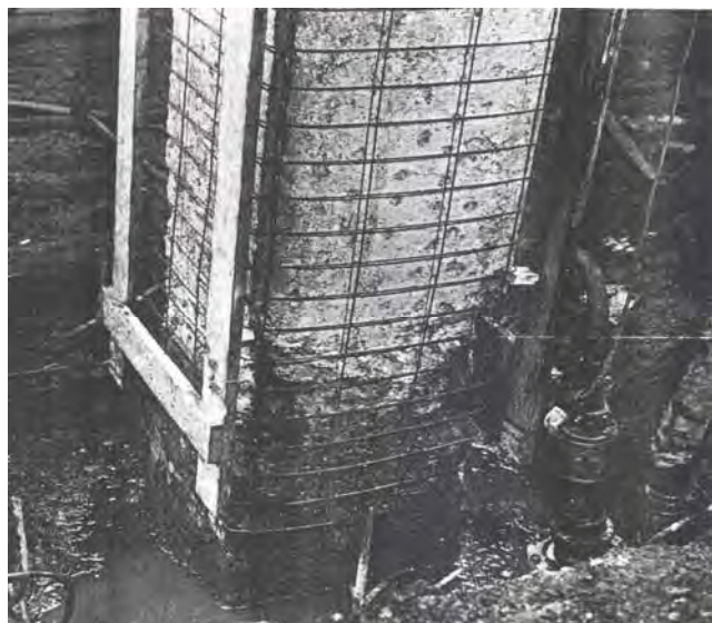
ب- اجرای روکش بتنی با بتن پاشی
