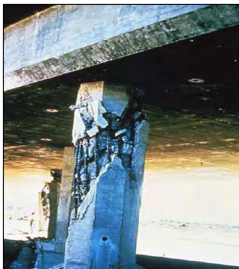
شکل ۲-۵-۱- نمونه‌ای از شکست برشی ستون
