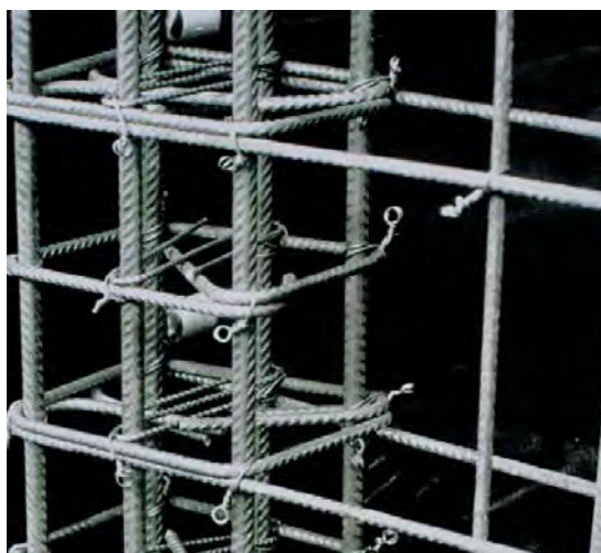
شکل ۳-۱۶ - اجرای جزئیات مناسب و شکل‌پذیر در ستون‌ها
