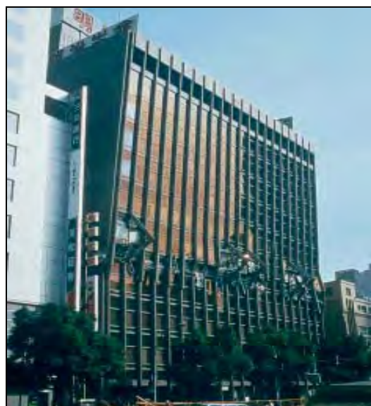
شکل ۳-۲- الف- وجود طبقه نرم در اولین تراز، ب- وجود طبقه نرم در طبقات بالایی
