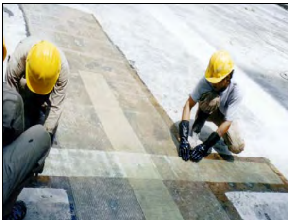
شکل ۱۱-۳-۲- مقاوم‌سازی دال در لنگرهای منفی بوسیله FRP
