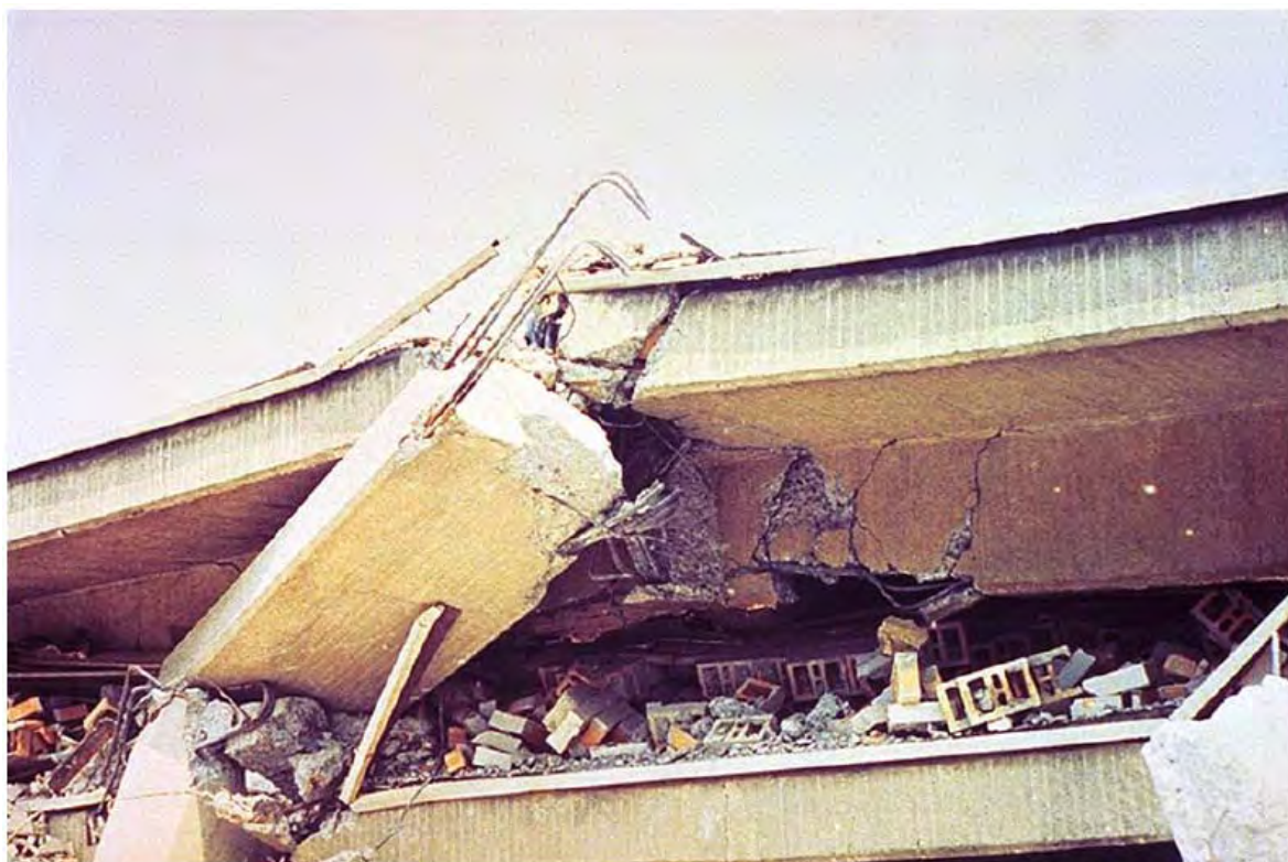
شکل ۲-۶-۱۰ وجود درز سرد در محل اتصال
