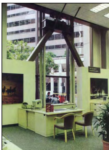
شکل ۷-۱۳- نمونه هایی از بکارگیری میراگر T-ADAS
