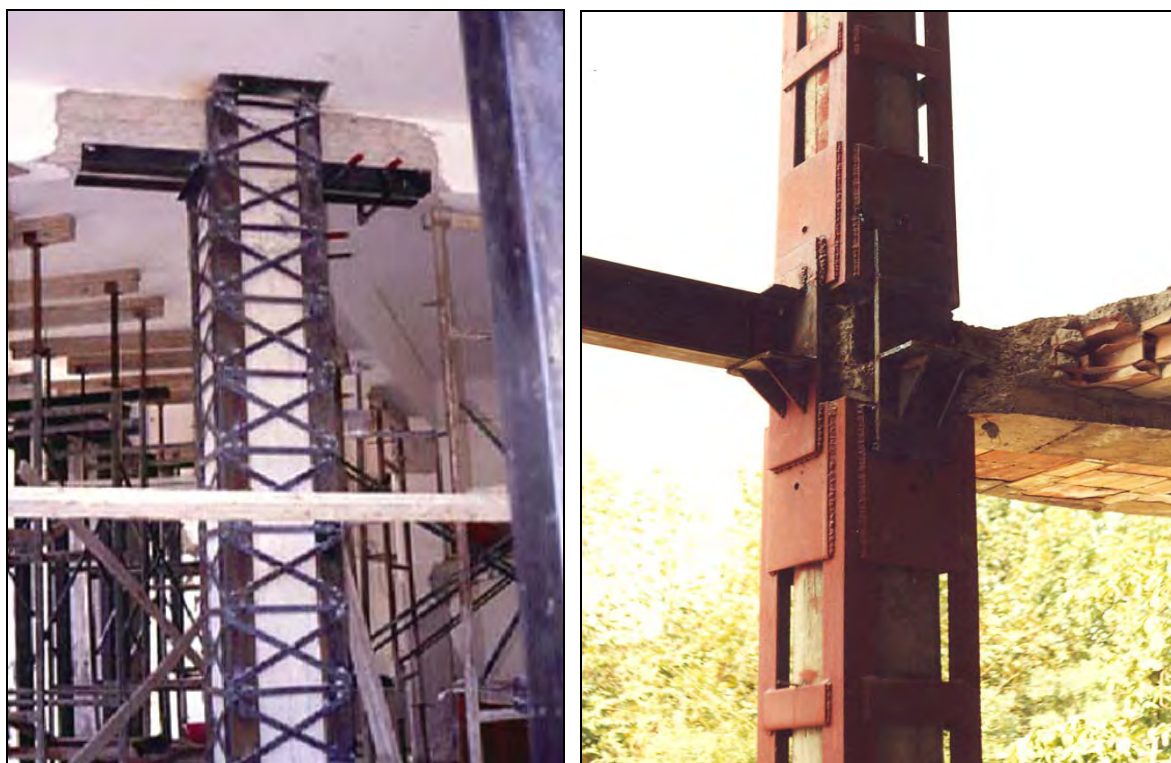
شکل ۲-۶-۲۵ روش‌های بهسازی اتصالات میانی
