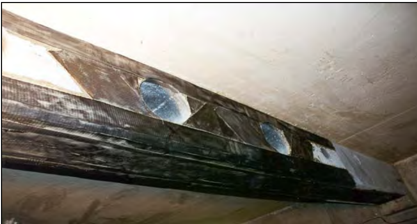
شکل ۲-۴-۱۵- تقویت موضعی سوارخ‌ها در تیر FRP
