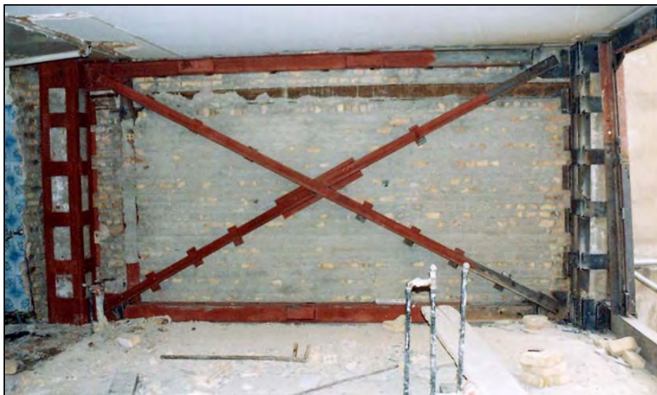
شکل ۴-۵- بهسازی قاب‌های موجود بوسیله مهاربندهای همگرا
