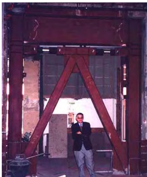
شکل ۷-۱۸- استفاده از میراگرهای ویسکوز در بادبندهای جناقی
