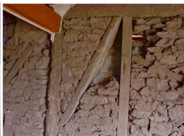
پ: ریزش تکه‌هایی از مواد پرکننده
