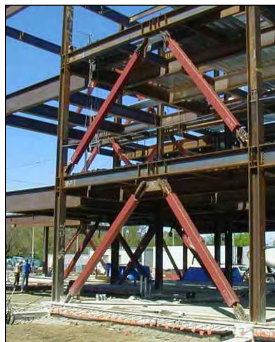
شکل ۴-۱۹- نمونه‌هایی از مهاربند ضد کمانش BRBF
