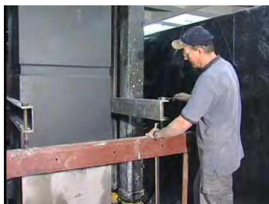
شکل ۶-۱۸ - نصب سازه خرابایی نگهدارنده
