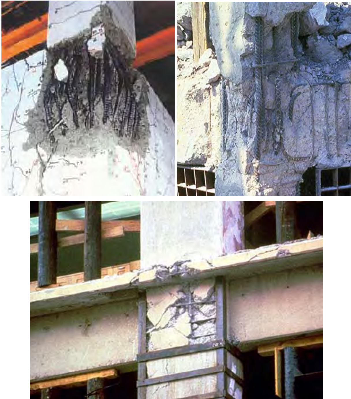
شکل ۲-۶-۷ کمانش میلگردهای طولی ستون در ناحیه اتصال
