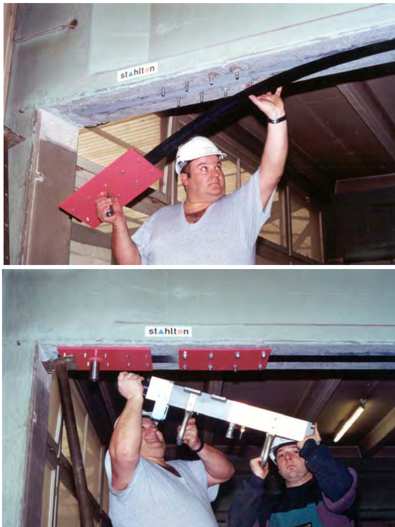
شکل ۲-۴-۱۷- روش پیش‌تنیدگی در صفحه FRP
