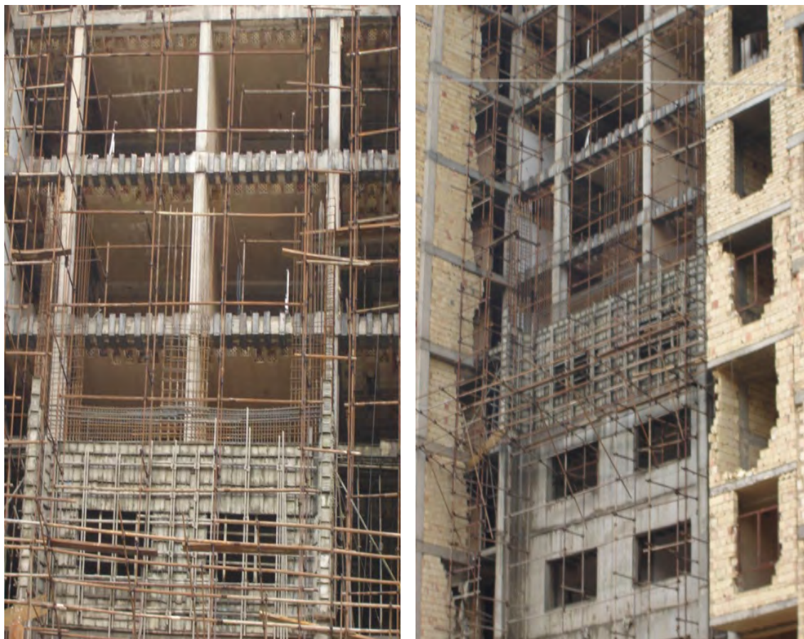
شکل ۴-۴۷ - افزودن میانقاب بتنی به عنوان دیوار برشی
