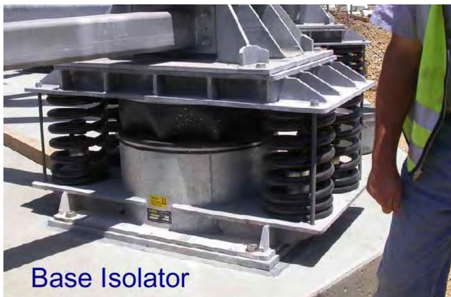
شکل ۶-۱۲- جداگر GERB
