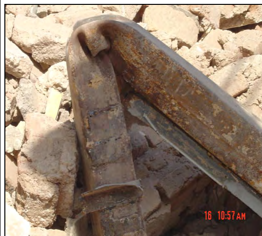
شکل ۲-۵-۱۹- نمونه‌ای از خرابی ستون‌های فولادی
