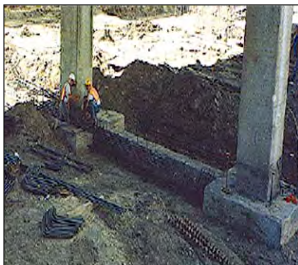
شکل ۴-۲-۲- به هم بستن شالوده‌ها با شناژ
