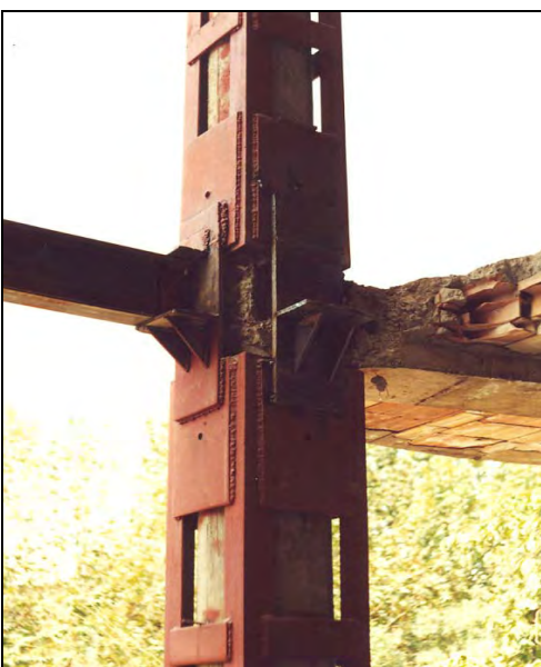
شکل ۲-۵-۱۲- نمونه‌ای از روکش فولادی جهت افزایش مقاومت خمشی ستون
