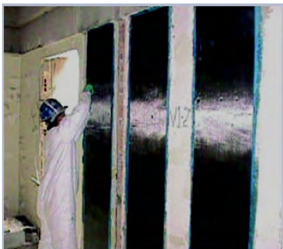
شکل ۸-۱۹ - نحوه اجرا و نصب نوارهای FRP
