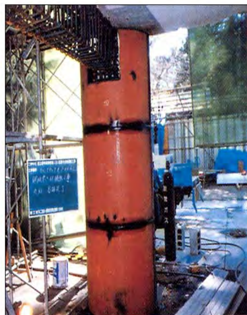
شکل ۲-۵-۱۴- استفاده از روکش فولادی مدور در بهسازی ستون‌های مستطیلی
