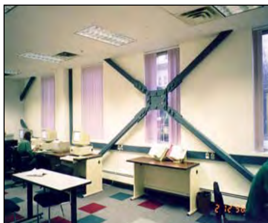
ادامه شکل ۷-۶- استفاده از میراگرهای اصطکاکی پال (Pall) در مقاوم سازی
