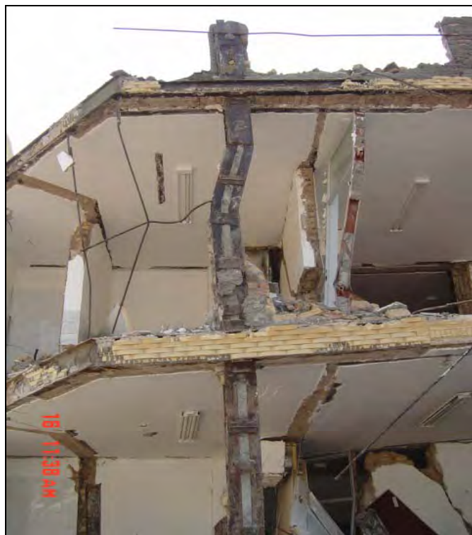
شکل ۲-۵-۱۹- نمونه‌ای از خرابی ستون‌های فولادی
